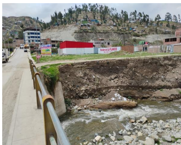
IMAGEN 03: SE MUESTRA EL TALUD EROSIONADO REQUIERE CONSTRUCCION DE MURO PARA PROTECCION DE LA TROCHA
