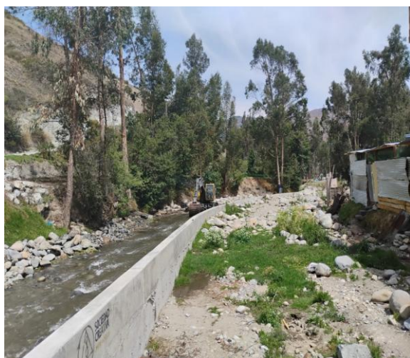
IMAGEN 01: SE MUESTRA EL ESTADO ACTUAL DEL RIO CHUMBAO DONDE EXISTE UN MURO DE CONCRETO EN EL EJE DE CAUCE Y EN EPOCAS DE AVENIDAS SOBREPASA EL AGUA LA ESTRUCTURA
